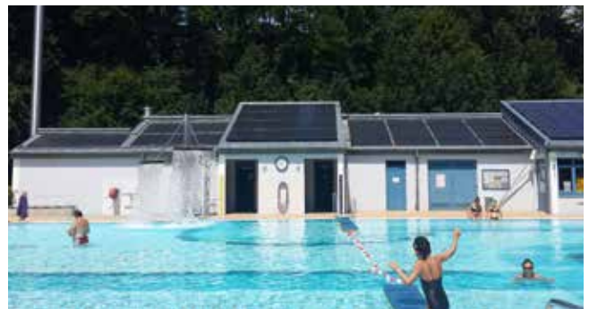
Dachmontage Freibad Mühldorf am Inn
