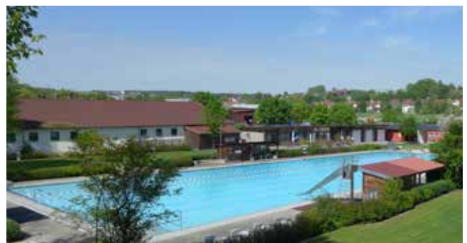
Dachmontage Freibad Arnstorf
