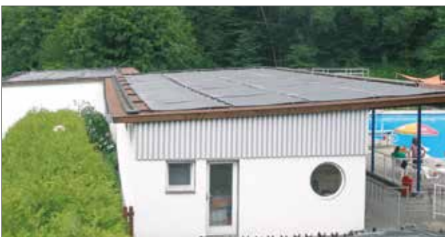
Dachmontage Freibad Holzhausen
