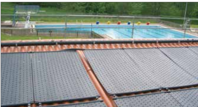
Dachmontage Freibad Knüllwald-Remsfeld
