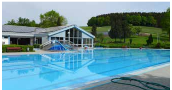
Dachmontage Freibad Gramming
