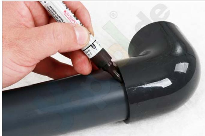
Vor dem Verkleben ist stets die Reihenfolge des Zusammenbaus zu prüfen, sowie die Position der Formteile. Für eventuelle Korrekturen stehen später nur wenige Sekunden zur Verfügung, der Kleber härtet sehr schnell aus.
